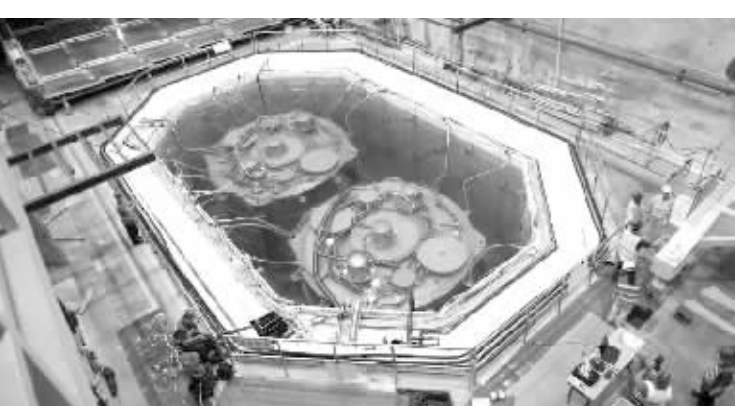
大亚湾实验中,中微子探测器被安装在水池中。(图片由中国科学院高能物理所提供)
