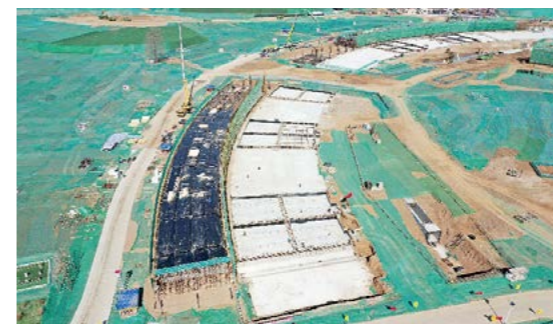
储存环实验大厅施工 (四区) (2020 年 3 月拍摄)
