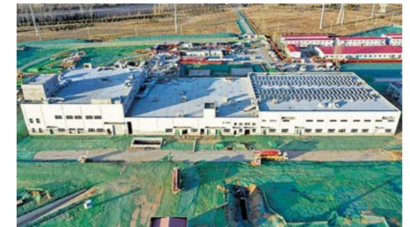
5 月 19 日, 综合动力站建筑主体结构封顶
