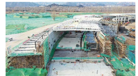
储存环实验大厅施工 (四区) (2020 年 12 月拍摄)
